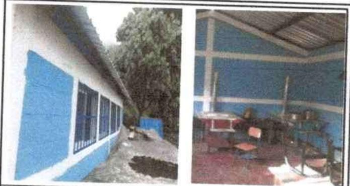
Foto 8: Cocina. Pintura de paredes interiores y exteriores, colocación de ventanas y balcones e instalación de estufas rurales terminado.
