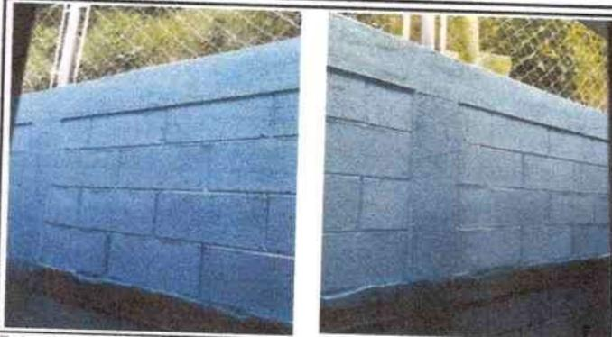
Foto 7: Construcción de muro perimetral de blok, tubos P/cerso y malla galvanizada terminado.
